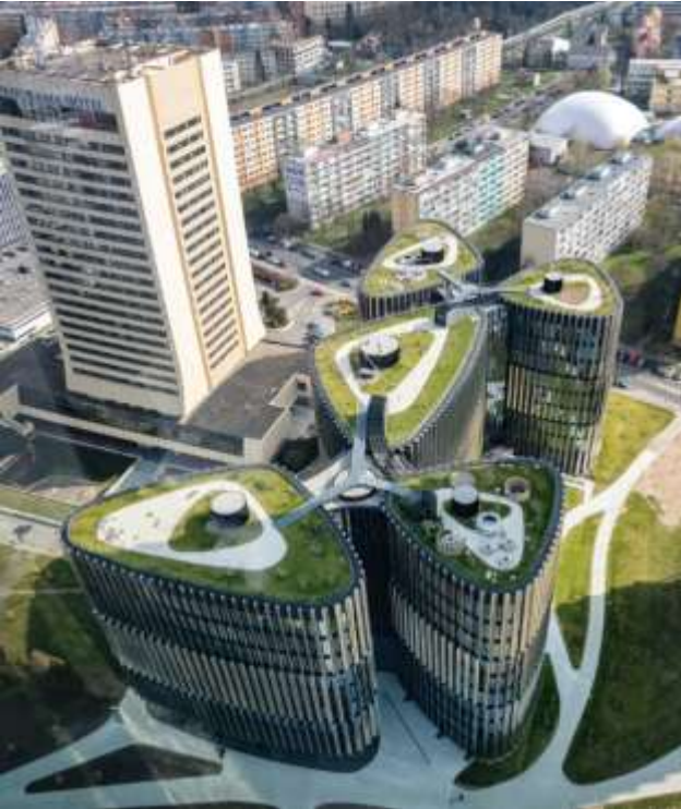
© Verband für Bauwerksbegrünung; Optigrün
